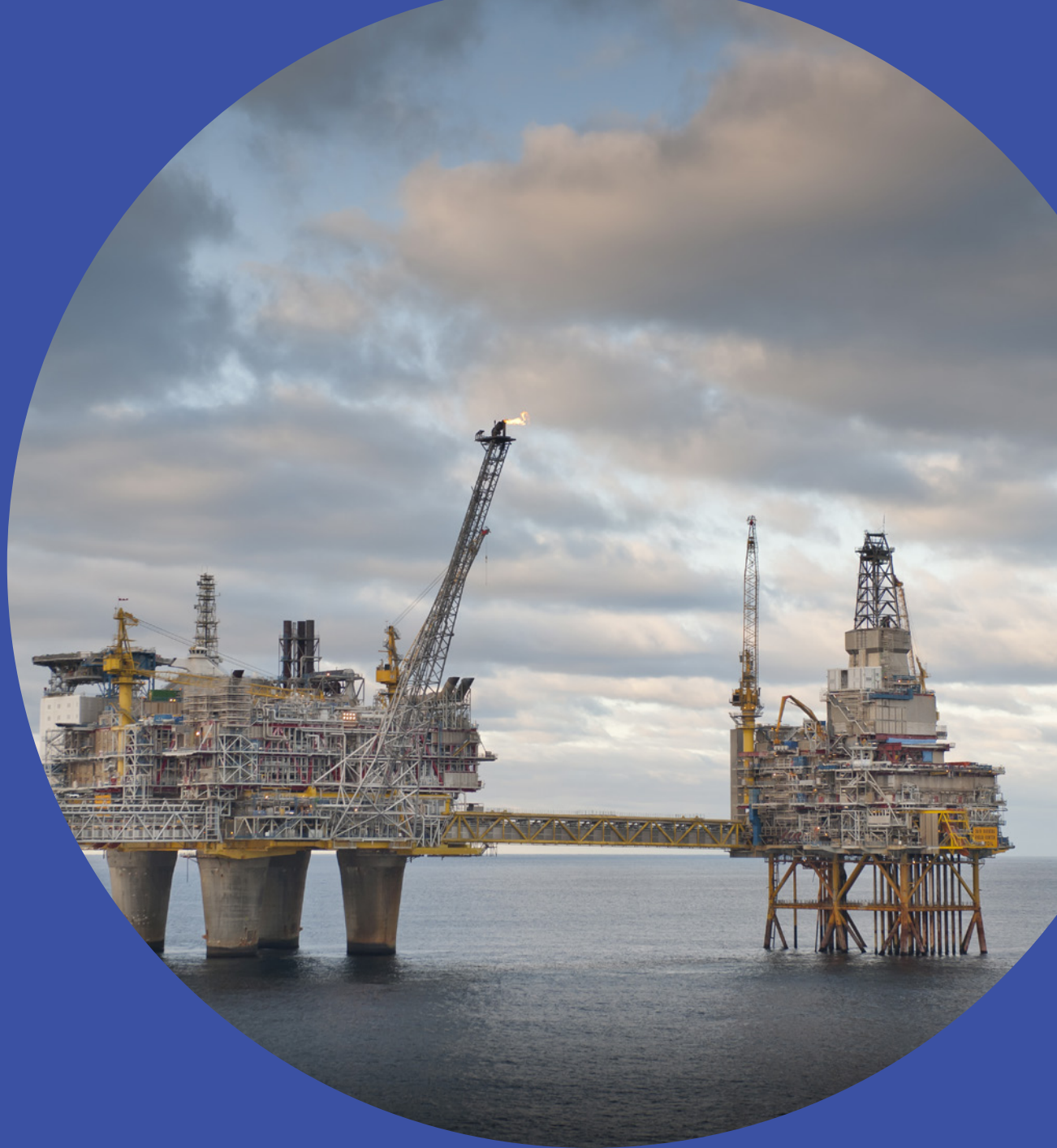
Oseberg Field Centre Foto: Øyvind Hagen / ©Equinor
